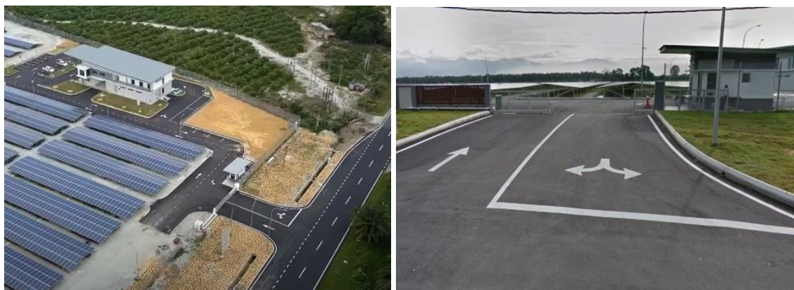
Foto 20: Contoh Akses Pembangunan di LSS Bidor, Perak
