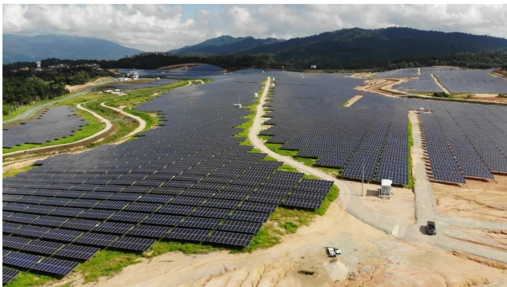
Foto 4: Pembangunan Ladang Solar Atas Tanah
