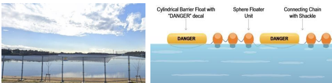
Foto 15: Pagar Keselamatan di Sekeliling Ladang Solar Atas Permukaan Air di Yamakura, Jepun (kiri) dan Contoh Ilustrasi Penghadang Solar Atas Permukaan Air untuk Mengelakkan Pencerobohan di Kolam Takungan Bedok, Singapura (kanan)
