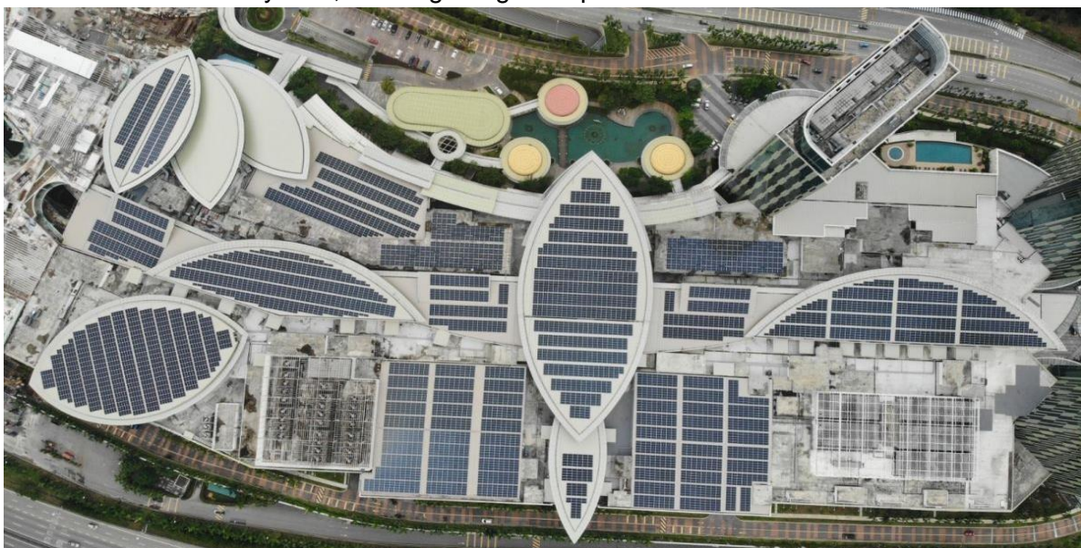
Foto 24: Pembangunan Solar yang Diintegrasikan dengan Bumbung Bangunan (BIPV) di IOI City Mall, Serdang dengan Kapasiti Janaan 3.5MW
