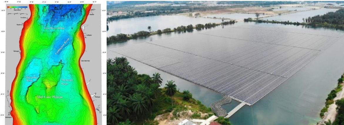
Foto 23: Pelan Batimetri (kiri) dan Pembangunan Ladang Solar di Atas Permukaan Tasik Bekas Lombong Berbentuk Seragam di Sepang, Selangor (kanan).
