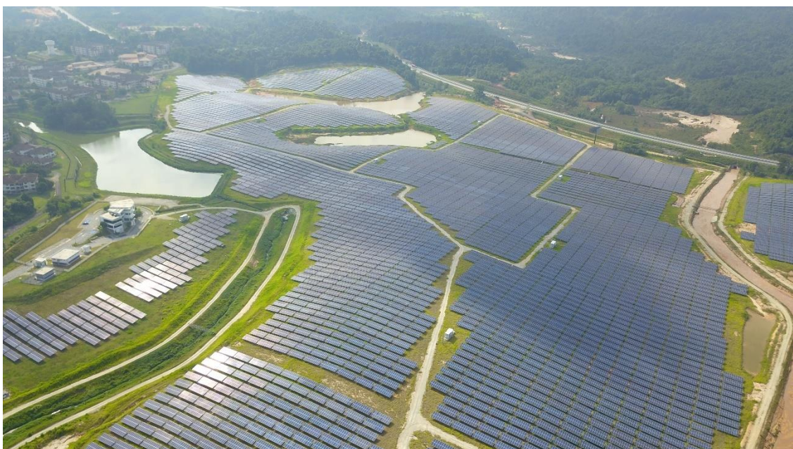
Foto 3: Contoh Pembangunan Ladang Solar di Gambang, Pahang Dengan Kapasiti 50MW
